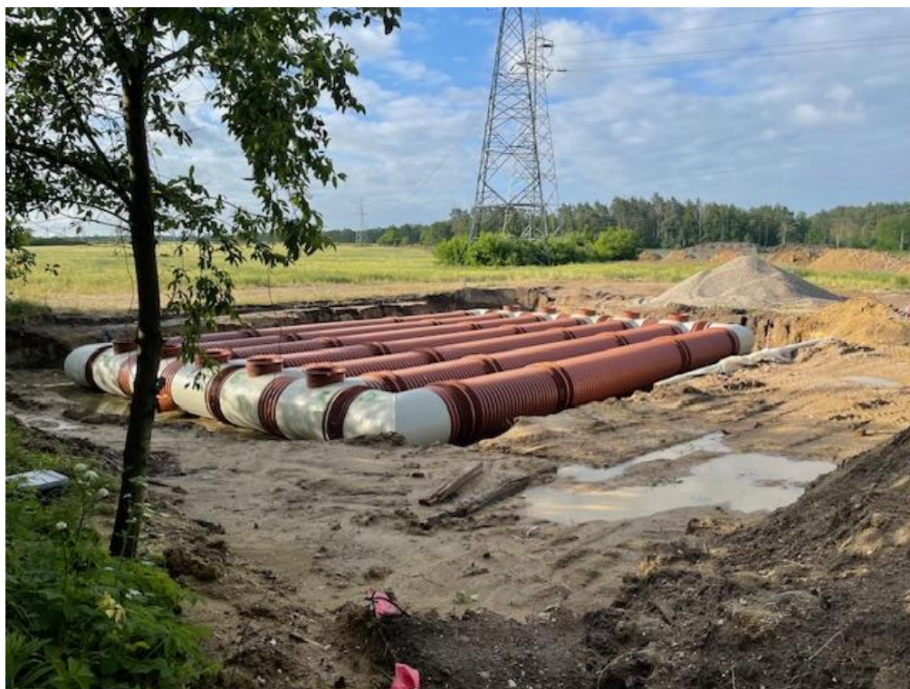
Rysunek 6.3 Podziemne zbiorniki retencyjne przy ul. Niedźwiedziej [UM]
