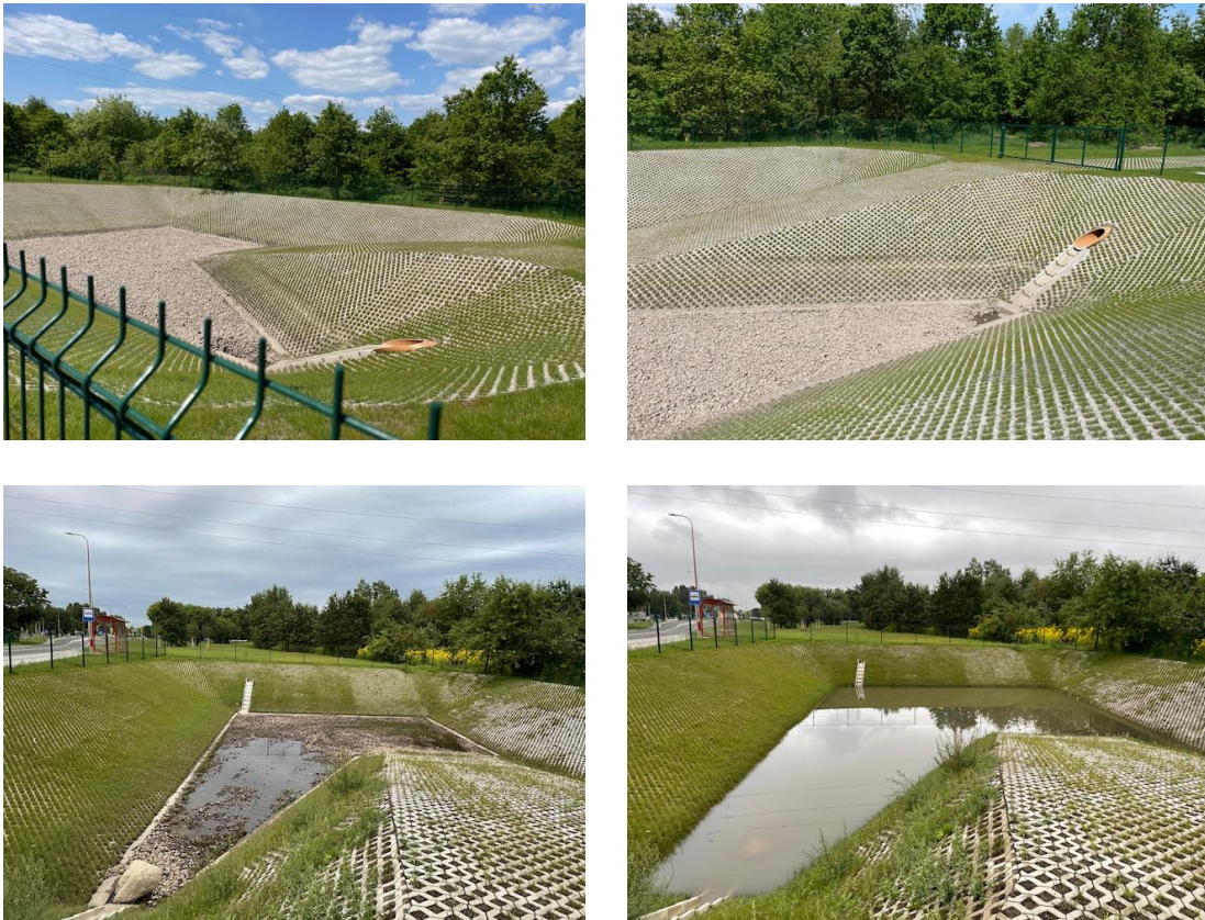
Rysunek 6.6 Otwarty zbiornik retencyjny przy ul. Spacerowej [UM]
