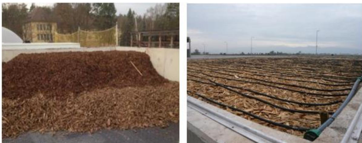
Zdjęcie 3. Materiał biofiltra na podłodze napowietrzającej (po lewej); Nawadnianie (po prawej)
