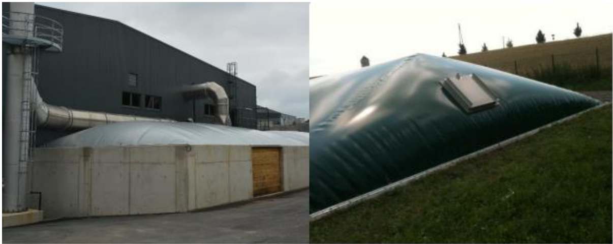
Zdjęcie 2. Zakryte biofiltry – z kominem wydechowym (po lewej); z otworem inspekcyjnym
