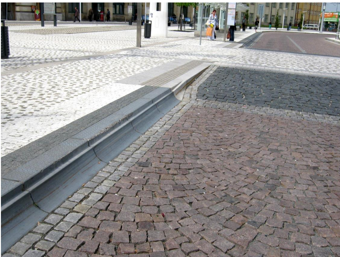
Rys. 20 Specjalny krawężnik przystankowy zastosowany w zintegrowanym węzle przesiadkowym przed głównym dworcem kolejowym w Hradec Králové (Czechy)
